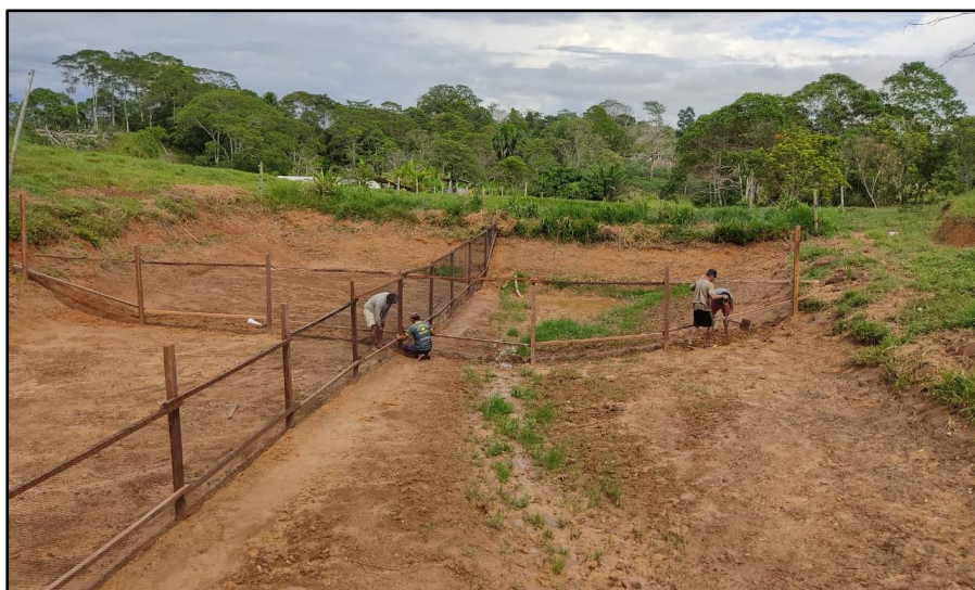
Figura 3. Vista del proceso de construcción de los cuatro corrales para el manejo de reproductores.
